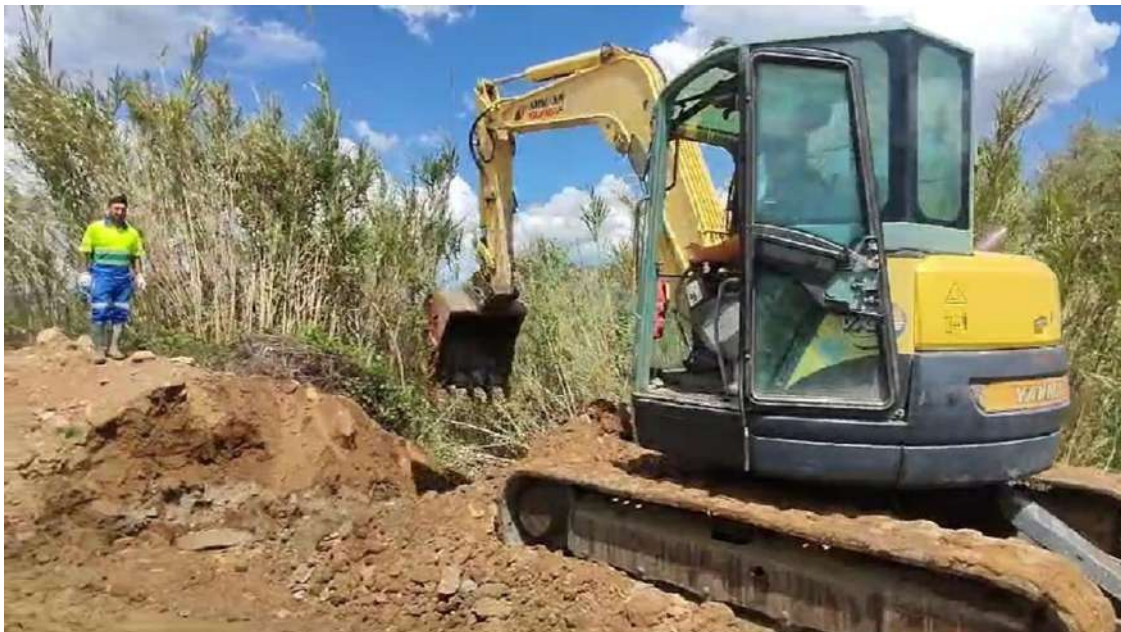
Los operarios de Aqualia trabajarán este miércoles sobre el terreno para reparar la tubería principal de agua en Cártama.
